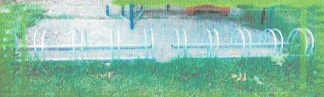
Instalace nových odpadkových košů, stojanů na kola
