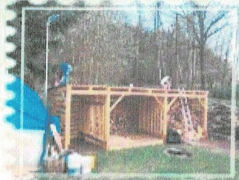
Přístřešek na dřevo
