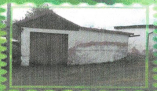
Legalizace objektu bývalé malé hasičárny, přidělení č. evidenčního, instalace protipožárních dveří a sádkartonových podhledů
