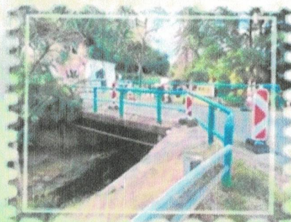
Oprava zábradlí a odvodnění na mostě
