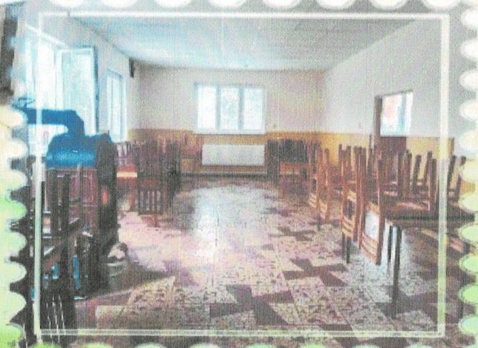
Oprava zdiva, stropu a výmalba prostor v hostinci U bobra, výroba nového pultu
