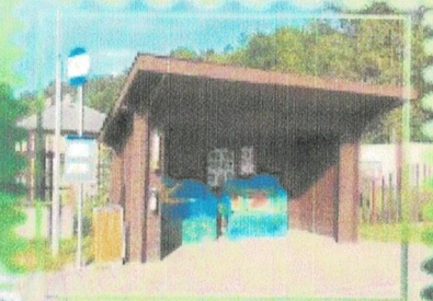
Oprava autobusové zastávky
